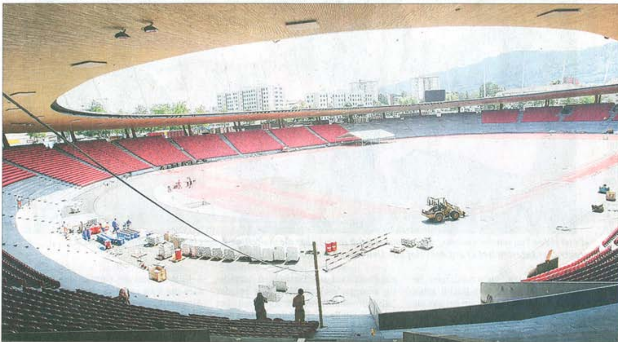
Für die Stahlbauer ist der Bau des neuen Letzigrund-Stadions abgeschlossen. Derzeit werden die Sitzplätze montiert. (Herbert Zimmermann)
